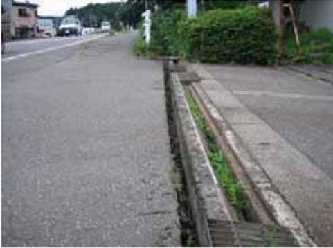
入口側溝が歩道側から押されて半分の幅になり、グレーチングが飛ばされた。
