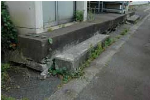
東側ライブラリー玄関の基礎周りが10cmほど陥没。先の中越地震の陥没と合わせて20cmほどに段差が広がった。
